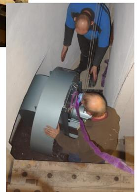
Fachsprache „des Winderzeugers“. Mit großer Seilwinde wurde er erst auf das hohe Gerüst gehoben, danach durch die großen Prospekt Pfeifen manövriert und dahinter wieder „abgeseilt“ und in die enge Nische eingepasst. Alles hat wie am Schnürchen geklappt. Es wurden neue groß dimensionierte Luftkanäle zum Blasebalg in der Orgel gebaut. Heute wurde zum ersten Mal wieder Luft in die alte Orgeldame geblasen!
